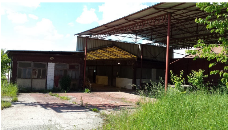
Dvorište zgrade, nadstrešnice i radionice
